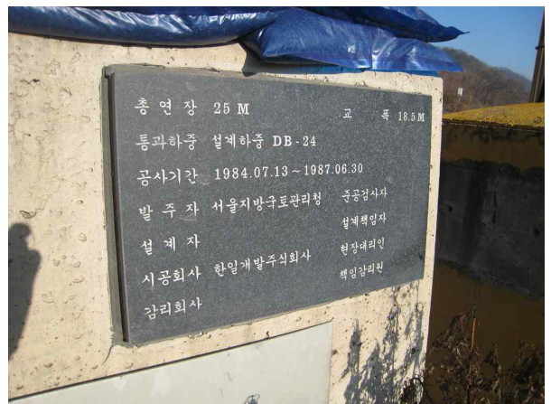
교량 설명판 전경
